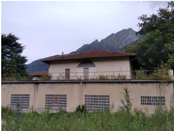
Esterno fabbricato D)
