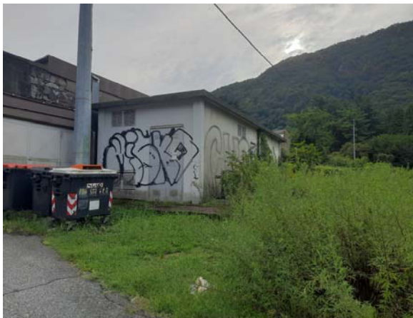
Esterno fabbricato D)
