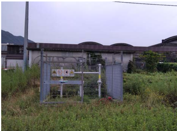
Esterno fabbricato D)
