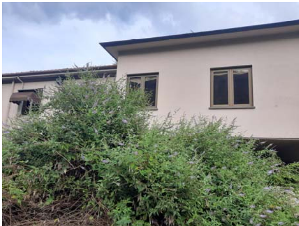
Esterno fabbricato B)
