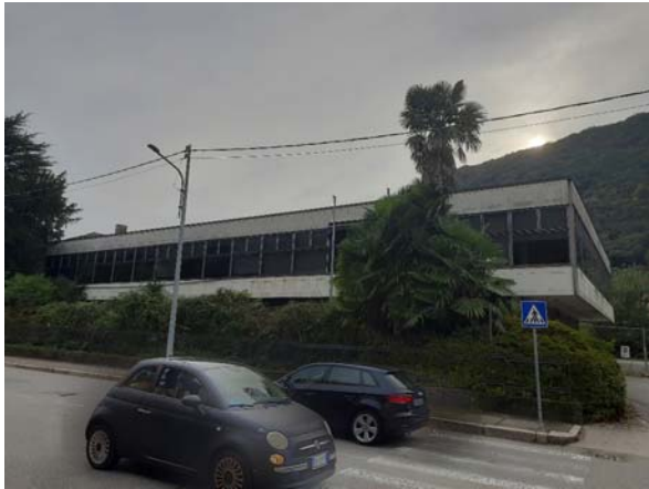
Esterno fabbricato A)
