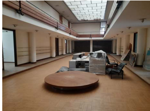
Interno fabbricato A)
