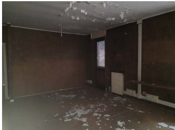
Interno fabbricato C)
